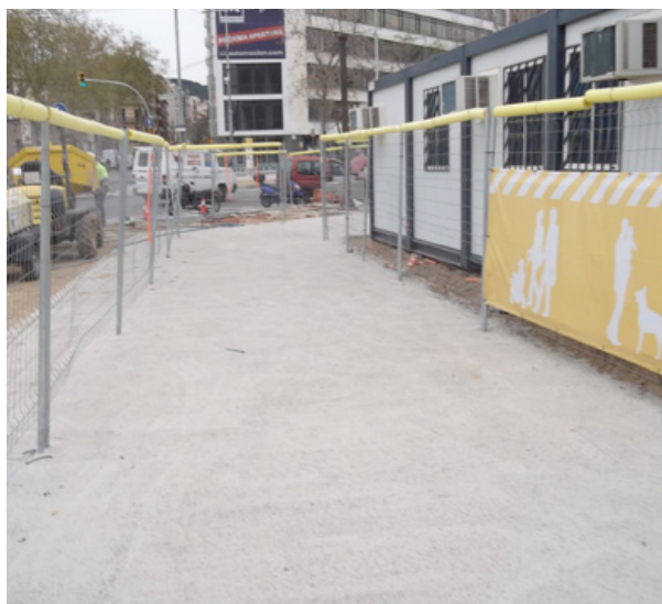
Tanques de protecció de la zona d'obres.
