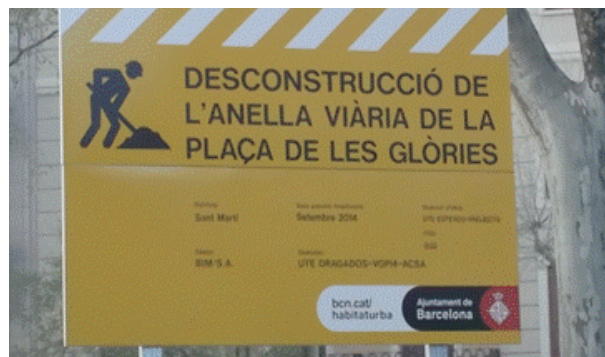
Reiteració d'informació en el tram de Gran Via previ a l'enllaç amb la rampa en obres.
