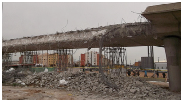
La màxima afectació a la mobilitat és deguda a la demolició de l'anella viària elevada.
