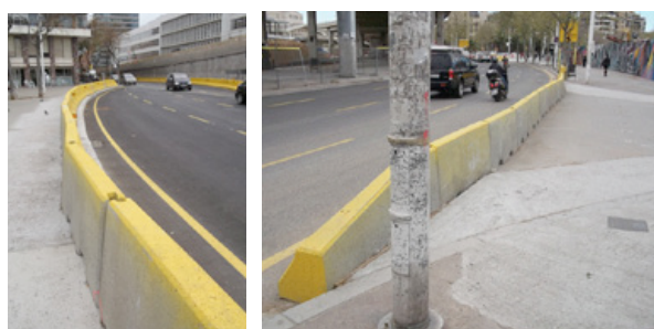
Barreres de formigó tipus New Jersey que separen vianants de vehicles.
