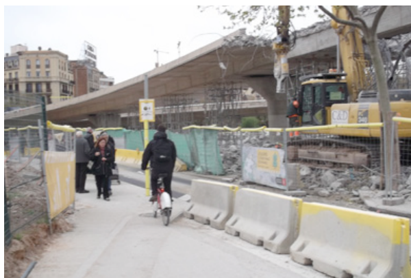
Voreres d'amplada insuficient al costat mar de Les Glòries.
