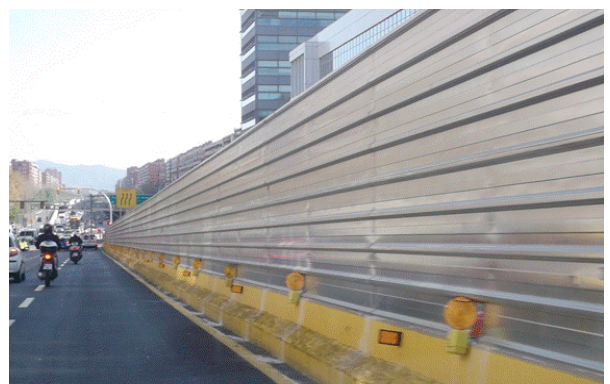
Perímetre de l'anella viària i rampes protegint per barreres de formigó.
